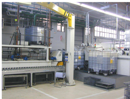
Depósitos de taladrina
