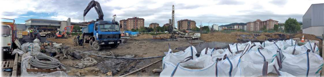
Perforación de los sondeos.
