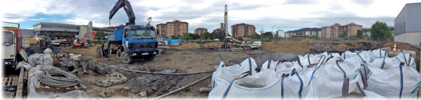
Perforación de los sondeos.
