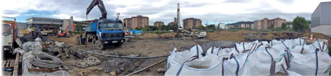
Perforación de los sondeos.
