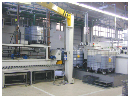
Depósito central de taladrina
