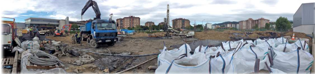
Perforación de los sondeos.
